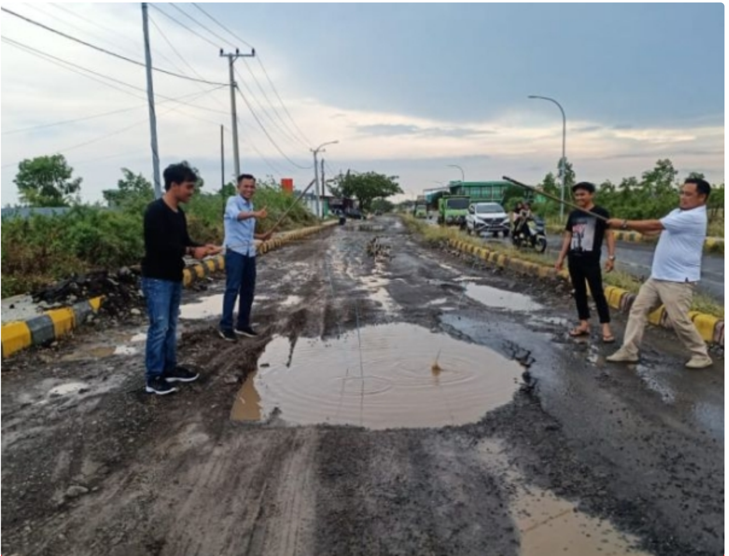
Telan Anggaran Rp13 M, Aspal Jalan Lingkar Kabupaten Jeneponto Rusak Parah.
